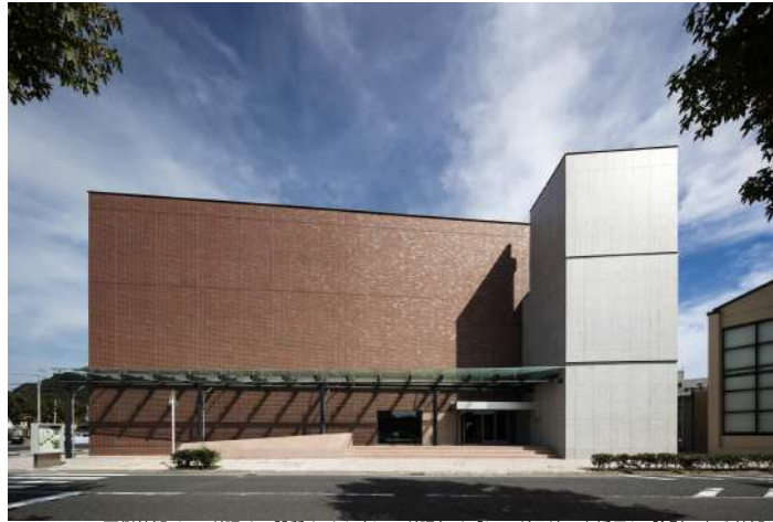
西側外観：レンガ調せり器質タイル(レンガ調)は「しのぎ目地」を採用し、陰影のある外観に
