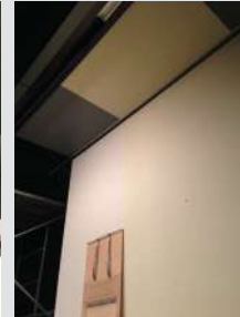
天井仕上げの検証
