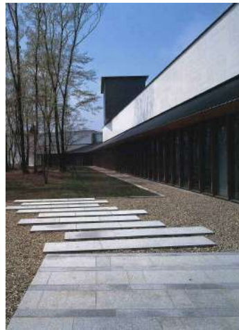
コリドールに面した外観 モノリシックな白磁のボーダータイルの壁と庇
