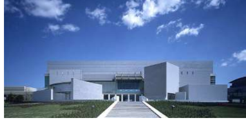
外観 (彫刻広場側)
